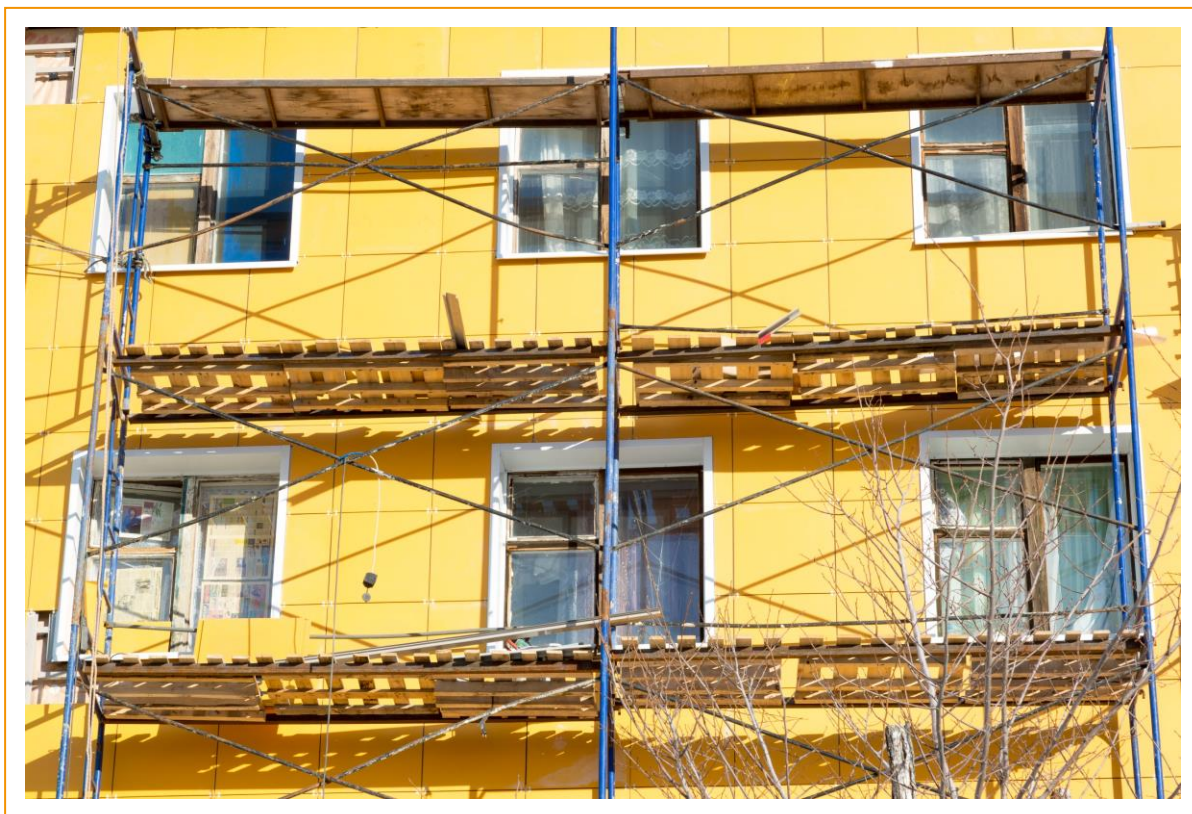
Рисунок 5 Работы по утеплению фасада административного здания в Германии. Источник фото: dena
